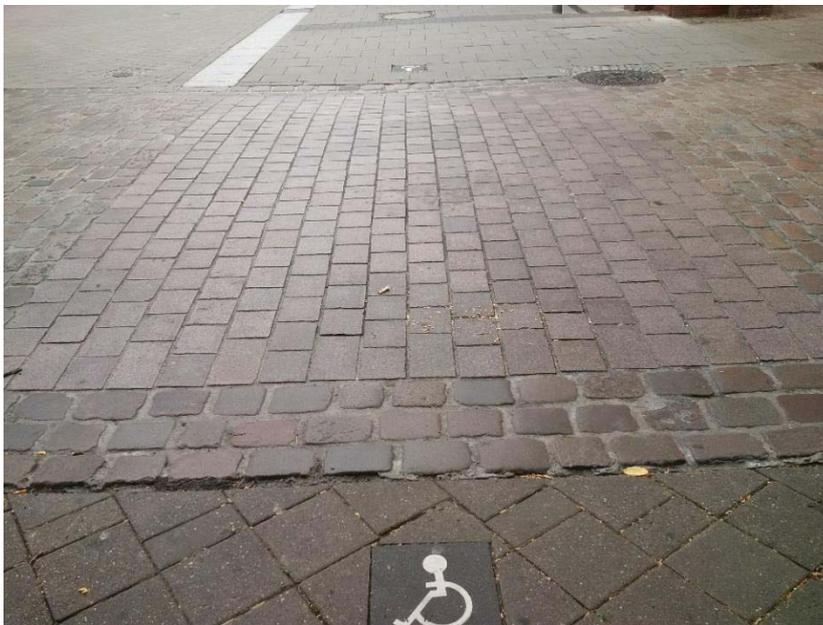
Abb.29: Erschütterungsarme Querungsmöglichkeit in Münster
