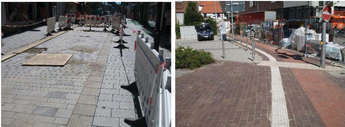
Abb. 21: Laufende Umbaumaßnahmen und Installation einer Leitlinie an der Münsterstraße
