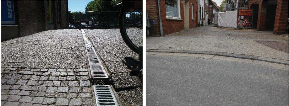
Abb. 9: Fortsetzung Stolperfallen: offener Regenkanal am Timmermannufer (l.), fehlende Bordsteinabsenkung an der Münstermauer/Kolpingstraße (r.)
