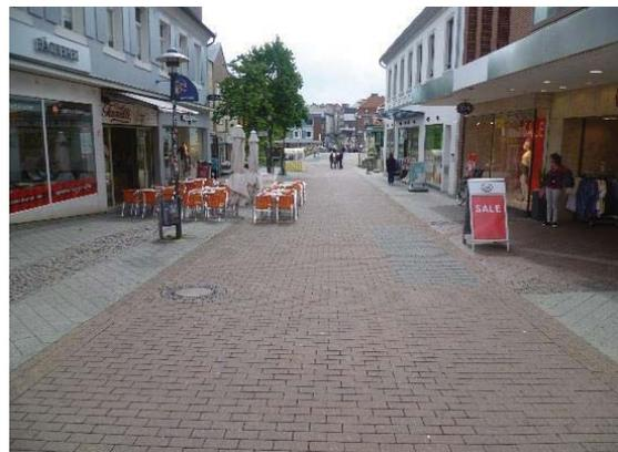
Abb. 10: Die Entwässerungsrinne wird „links der Ems“ als Leitlinie genutzt und fehlt „rechts der Ems“
