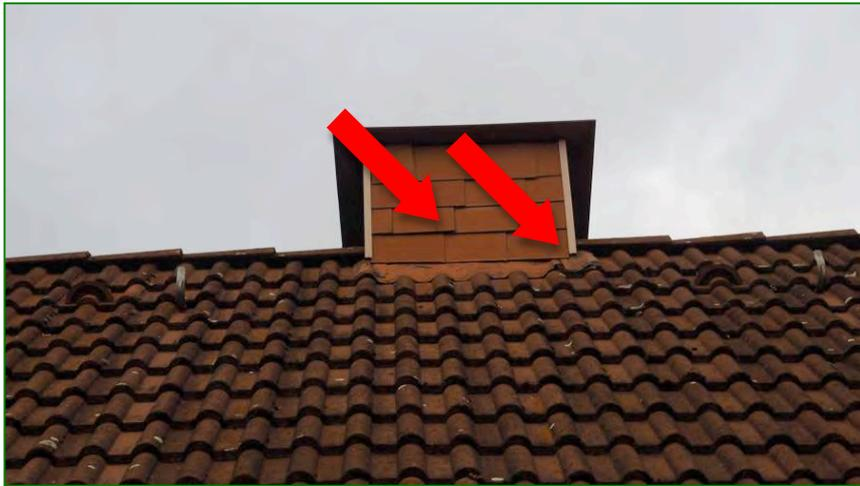
Abbildungen 3 und 4: Strukturen an schadhaften Verblendungen
