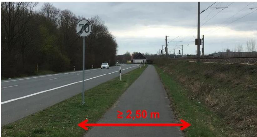
Abb. 6.2-2 Vorschlag: Ausbau der Radverkehrsanlage am Münsterlanddamm (außerorts) auf mind. 2,50 m
