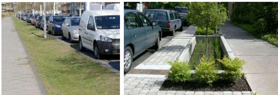
**Abbildung 5-3: Beispiel einer Mulde und eines Tiefbeets** [hamburg.de]
