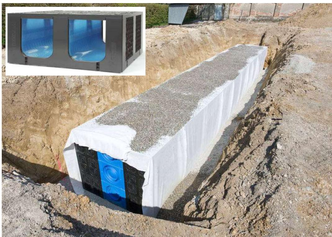
**Abbildung 5-4: Einbau von Speicherrigolen** [www.rehau.com]
