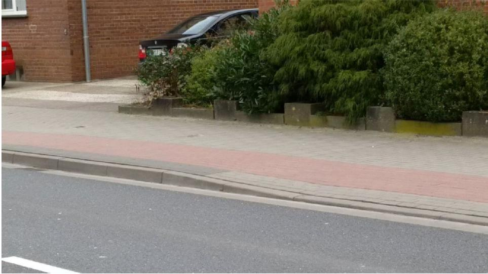
Die Absenkung des Hochbordes in der Zufahrt wird mit zwei Spezialbordsteinen mit einer Länge von 2,00 m von 12 cm auf 2 cm reduziert. Die Höhe an der Grundstücksgrenze wird beibehalten und nicht in gleicher Weise wie der Bord abgesenkt. Im Bereich des Absenkers entsteht eine Neigung von bis zu 5% durch die Überbrückung von einer Höhe von 10 cm auf 200 cm.
