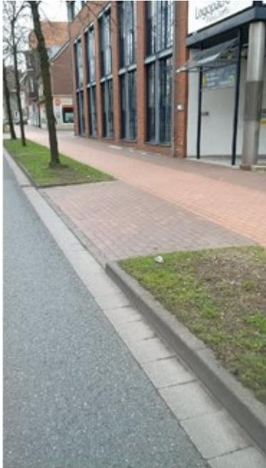
Der Hochbord endet auf beiden Seiten der Zufahrt ohne Absenker abrupt und wird auf der Breite des Sicherheitstrennstreifens rechtwinklig bis zur durchgehenden Nebenanlage (z.B. Geh- und Radweg) geführt. Der durchgehende Bord erhält die Höhe von  $h=2,00$  cm.
