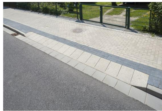
Der Hochbord wird im Bereich der Zufahrt um ca. 4 cm an das Höhenniveau der Einfahrtsschwelle abgesenkt. Geh- und Radwege bleiben von Quer- und Schrägneigungen frei. Es entstehen keine Rampen in den Nebenanlagen. Im Bereich der Schwelle entsteht eine Querneigung von bis zu 2%.
