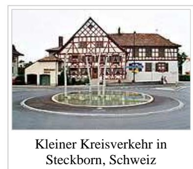
Während eine Kreuzung mit mehr als vier Zufahrten mittels Ampel wesentlich komplexer zu steuern ist, ist bei einem Kreisverkehr die Anzahl der möglichen Einfahrten nur von der Größe des Ringes abhängig. Er stellt prinzipbedingt jegliche Verkehrsbeziehung der angeschlossenen Straßen bereit.
