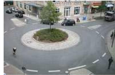
Kreisverkehre – in der Fachsprache Kreisverkehrsplatz genannt – haben in den letzten Jahren immer mehr an Bedeutung gewonnen. Sie stellen unter bestimmten Voraussetzungen eine gute und verkehrssichere Alternative zur herkömmlichen Regelung mit Ampeln dar. Jeder Einsatzfall muss individuell geprüft werden, da Kreisverkehre nicht nur Vorteile haben.
