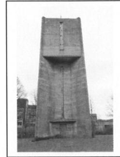
Der Wasserturm an der Hauenhorster Straße in Rheine stellt dabei eine besondere Bauform dar, der Behälter, ausgeführt als Stützbodenbehälter nach dem System Intze, ruht auf einem eigenen Stützenrahmen, die Fassade in Skelettbauweise ist dem Behälter vorgestellt.
