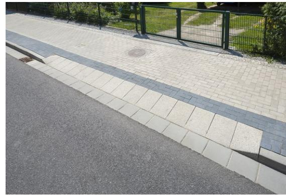
Der Hochbord wird im Bereich der Zufahrt um ca. 4 cm an das Höhenniveau der Einfahrtsschwelle abgesenkt. Geh- und Radwege bleiben von Quer- und Schrägneigungen frei. Es entstehen keine Rampen in den Nebenanlagen. Im Bereich der Schwelle entsteht eine Querneigung von bis zu 2%.
