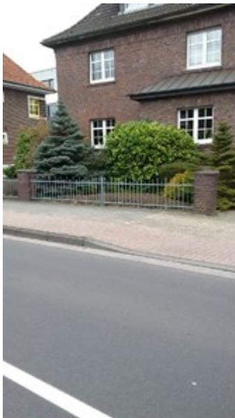
Die Absenkung des Hochbordes in der Zufahrt wird mit einem Spezialbordstein mit einer Länge von 1,00 m von 12 cm auf 2 cm reduziert. Die Höhe an der Grundstücksgrenze wird beibehalten und nicht in gleicher Weise wie der Bord abgesenkt. Im Bereich des Absenkers entsteht eine Neigung von bis zu 10% durch die Überbrückung von einer Höhe von 10 cm auf 100 cm.
