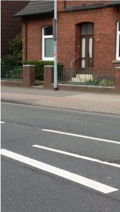
Die Absenkung des Hochbordes in der Zufahrt wird mit einem Spezialbordstein mit einer Länge von 2,00 m von 12 cm auf 2 cm reduziert. Die Verziehung des Höhenunterschiedes wird nur über die Breite des Sicherheitstrennstreifens ausgeglichen. Geh- und Radwege bleiben von Quer- und Schrägneigungen frei. Es entstehen keine Rampen in den Nebenanlagen. Im Bereich des Absenkers entsteht eine Längsneigung von bis zu 5% durch die Überbrückung von einer Höhe von 10 cm auf 200 cm.
