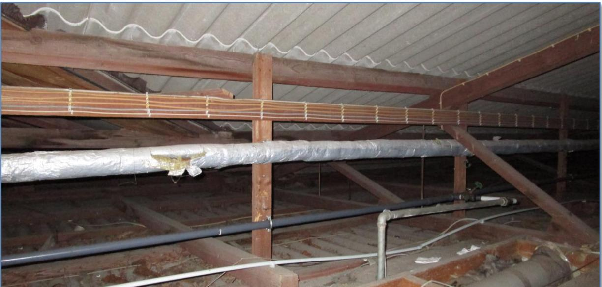
Abb. 6: Nichtisolierter Dachboden, z.T. ohne Stehhöhe, so genannter Kriechboden.
