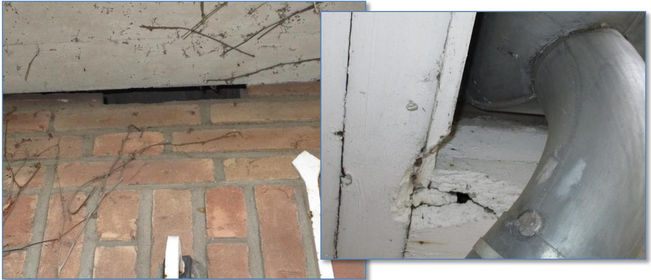
Abb. 7: Herausgefallener Verblender, Schlupfloch im Dachüberstand. Das sind die einzigen potentiellen Versteckmöglichkeiten am Gebäude.
