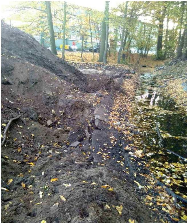
**Bild 27** (19.10.18): Abtrag des Oberboden- / Kieselrotgemisches bis an das Bachgerinne.
