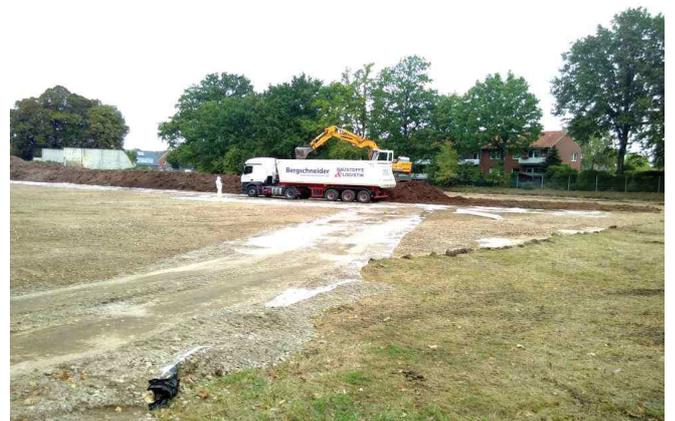
**Bild 9** (27.09.18): Verladung des aufgehaldeten Kieselrots.
