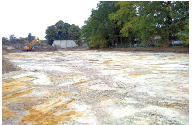
**Bild 19** (04.10.18): Blick über die Sanierungsfläche nach Nordwesten. Kieselrot und Schottertragschicht sind vom nördlichen Teil des Sportplatzes zu diesem Zeitpunkt entfernt.
