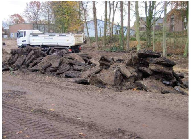
**Bild 43** (19.11.18): Aufgehaldete Betonplatten aus dem Bach vor der Verladung (Verbringung zur Deponie der EGST in Altenberge).
