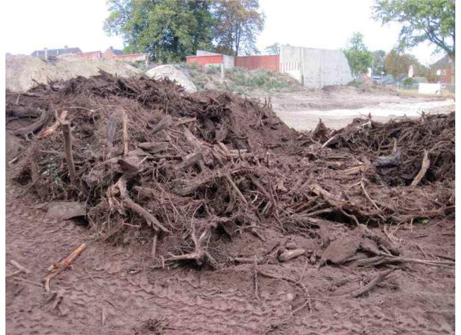
**Bild 32** (22.10.18): Baumwurzeln mit Kieselrotanhaftungen, die zur thermischen Beseitigung abgefahren wurden.
