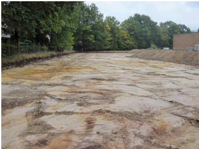
**Bild 12** (02.10.18): Vollständig abgezogene nördliche Fläche des Sportplatzes nach Abtrag Kieselrot und Schotter.
