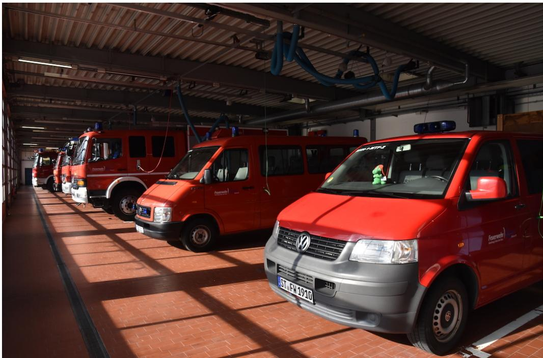
Abb. 7.3-12: FGH LZ links der Ems: Fahrzeughalle mit Abgasabsauganlage
