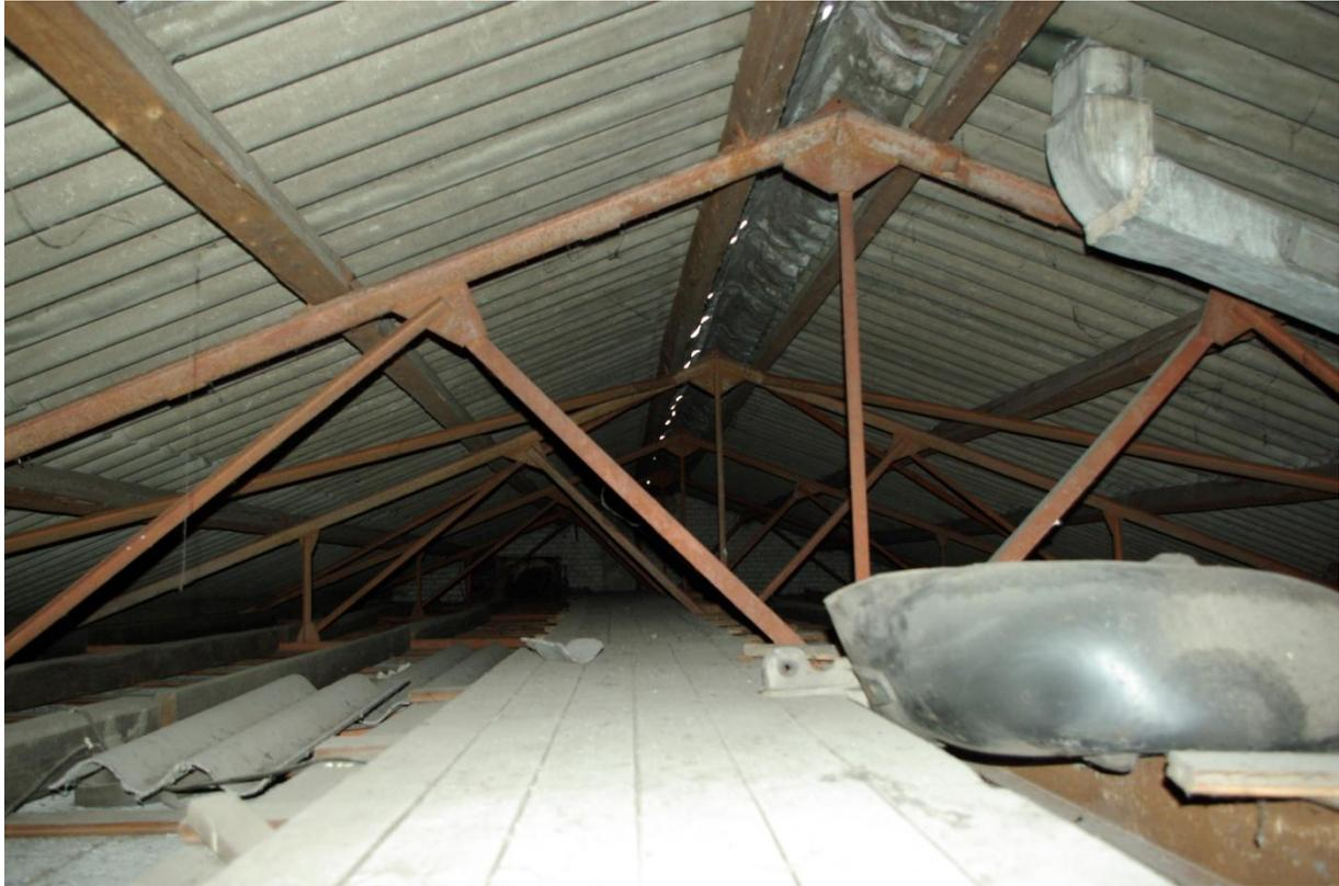
Abbildung 13: Dachraum eines der Lager- und Hallengebäude. Die Dächer sind mit Eternit eingedeckt und weisen mehrfach Spalten und Öffnungen auf.
