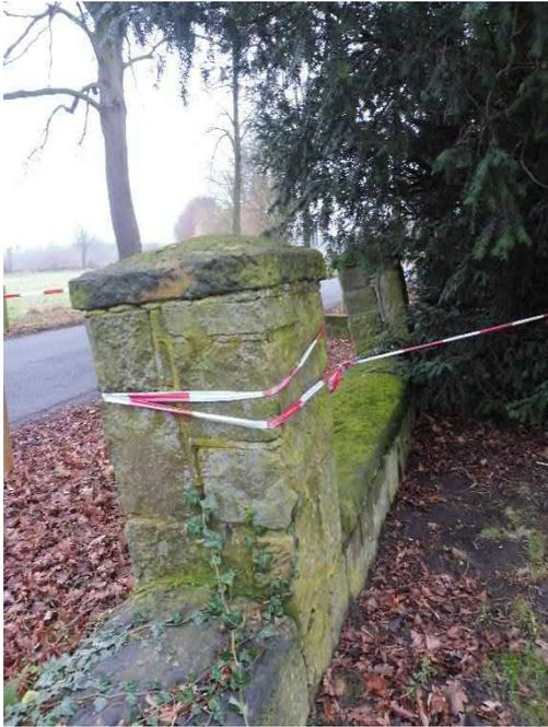
Die Ursachen sind: Wurzeldruck und vielleicht auch Aufweichung des Bodens durch Starkregenereignisse, denn das Wasser fließt von der Straße Richtung Mauer. Die weiteren Mauerstücke zeigen alle größtenteils deutlich sichtbare Neigungen, kein Stück steht mehr in der Waage (ich habe mit der Wasserwaage alle Elemente überprüft).
