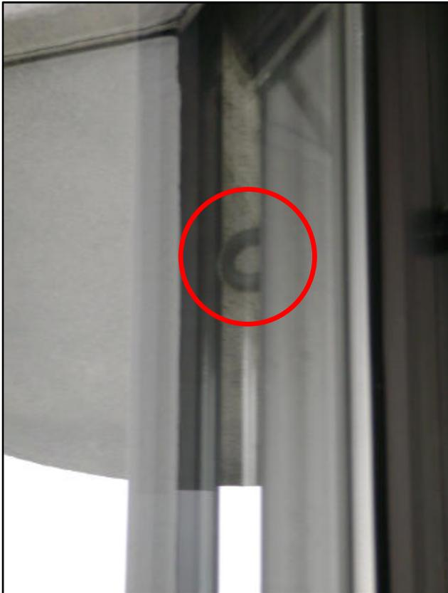
Stahlösen außen dienen zur Aufnahme der Sicherheitsgurte für die Fensterputzer.
