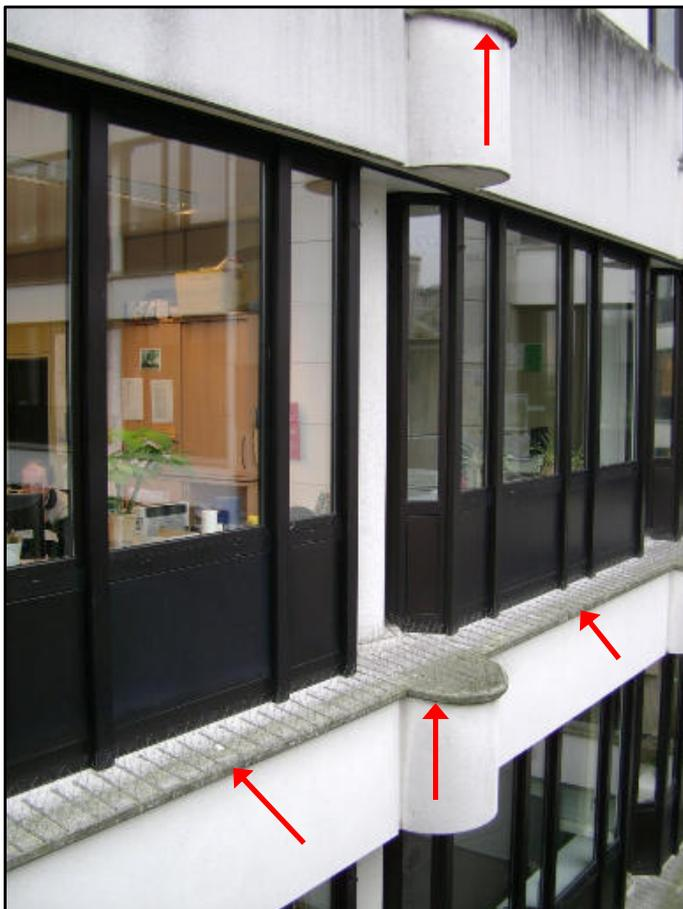
In den Zwischengeschosson sind die unteren Fensterabdeckungen in Betonteilen mit Abtropfkanten ausgeführt worden.
