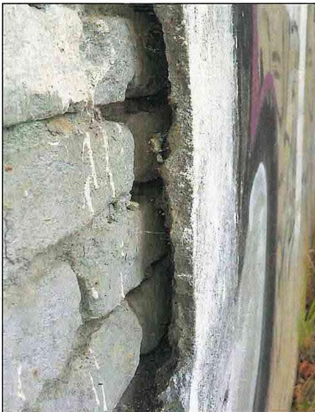
Foto 2 Spalte zwischen Mauerwerk und Putzresten, Quartiermöglichkeit für Spaltenbewohner
