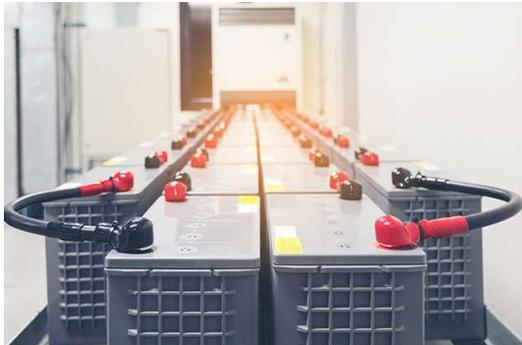
Stromspeicher in den Wohnhäusern oder im Bi-Direktionalem Stromarealnetz dienen dazu, kurzzeitige Abweichungen zwischen erneuerbarer Erzeugung und Energiebedarf im Gebäude- bzw. im Quartiersstromnetz auszugleichen. Zusätzlich können diese bei Bedarf der Stromnetzstabilisierung dienen. So sollen die Batteriespeicher z.B. genutzt werden, um zu jeder Zeit die erforderlichen Ladeleistungen für Elektromobilität bereitstellen zu können.
