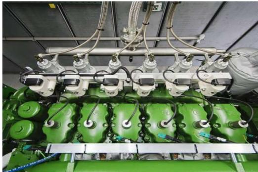
Ein Teil des produzierten „grünen Wasserstoffs“ kann direkt in der Energiezentrale energetisch verwertet werden. Wird in Zeiten ohne ausreichend Photovoltaik-Strom aus dem Quartier Strom und Wärme in den Gebäuden benötigt, lässt sich der Wasserstoff, der im Wasserstoff-Speicher (H<sub>2</sub>-Tank) an der Energiezentrale gespeichert werden kann mit den bivalenten Blockheizkraftwerken (H<sub>2</sub> und Biomethan) wieder schnell und einfach rückverstromen (P2G2P).
