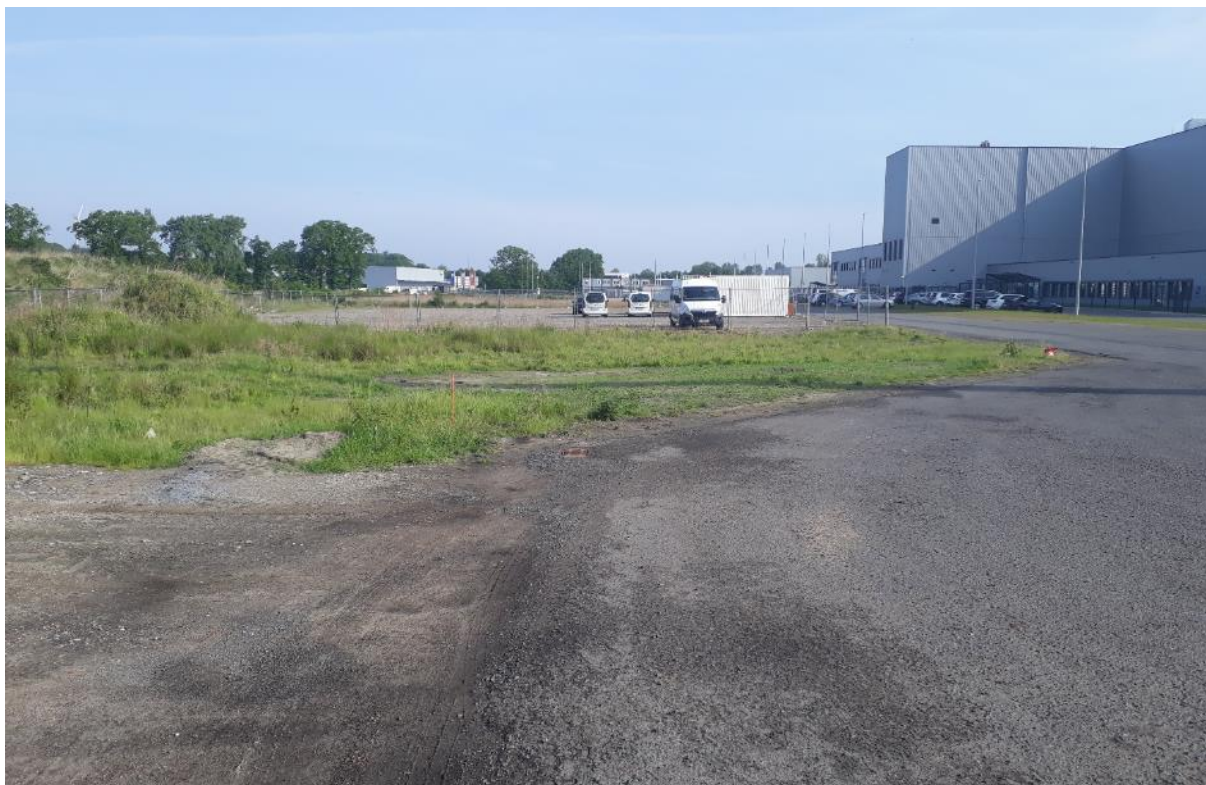
Foto 5: südlicher Wendepunkt der Siemensstraße, Bodenmieten und Schotter-Stellflächen im südwestlichen Industriegebiet
