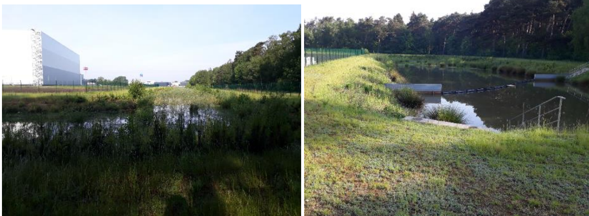
Foto 2 und 3: Regenklär- und -rückhaltebecken im nördlichen und nordöstlichen Plangebiet
