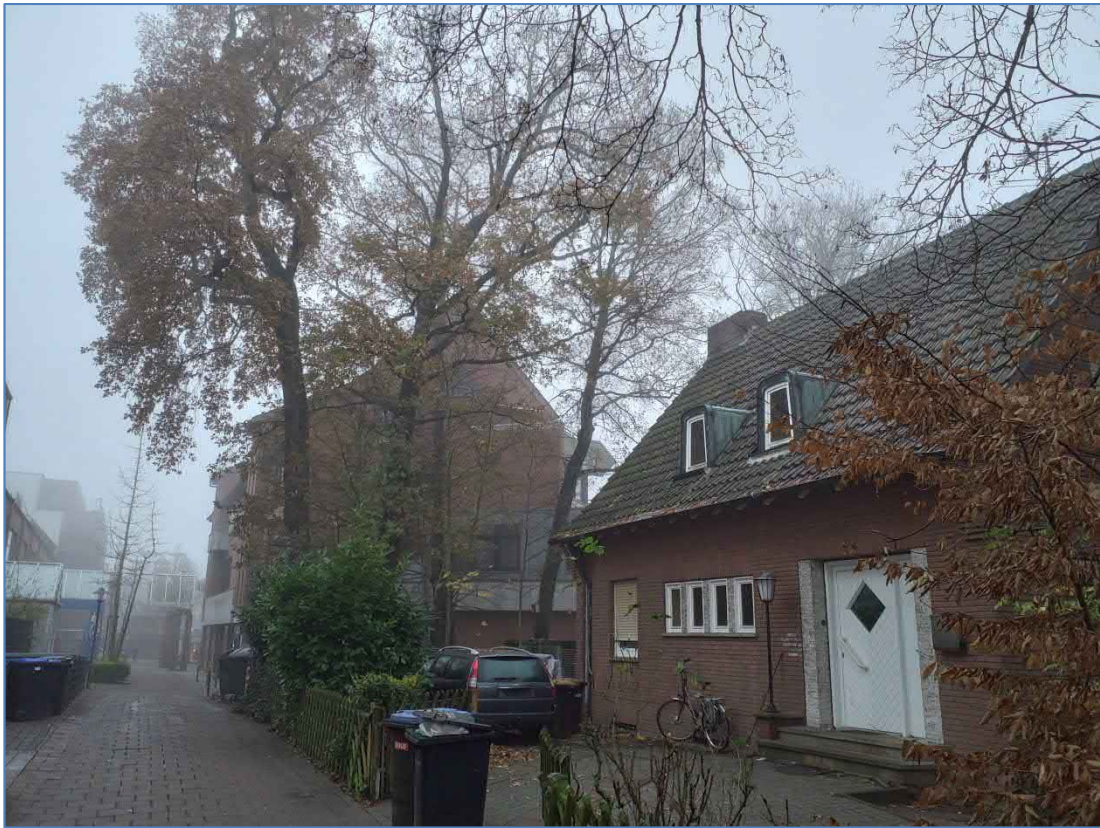
Abb. 4: Blick von der Bültstiege auf das abzureißende Gebäude Hausnr. 15
