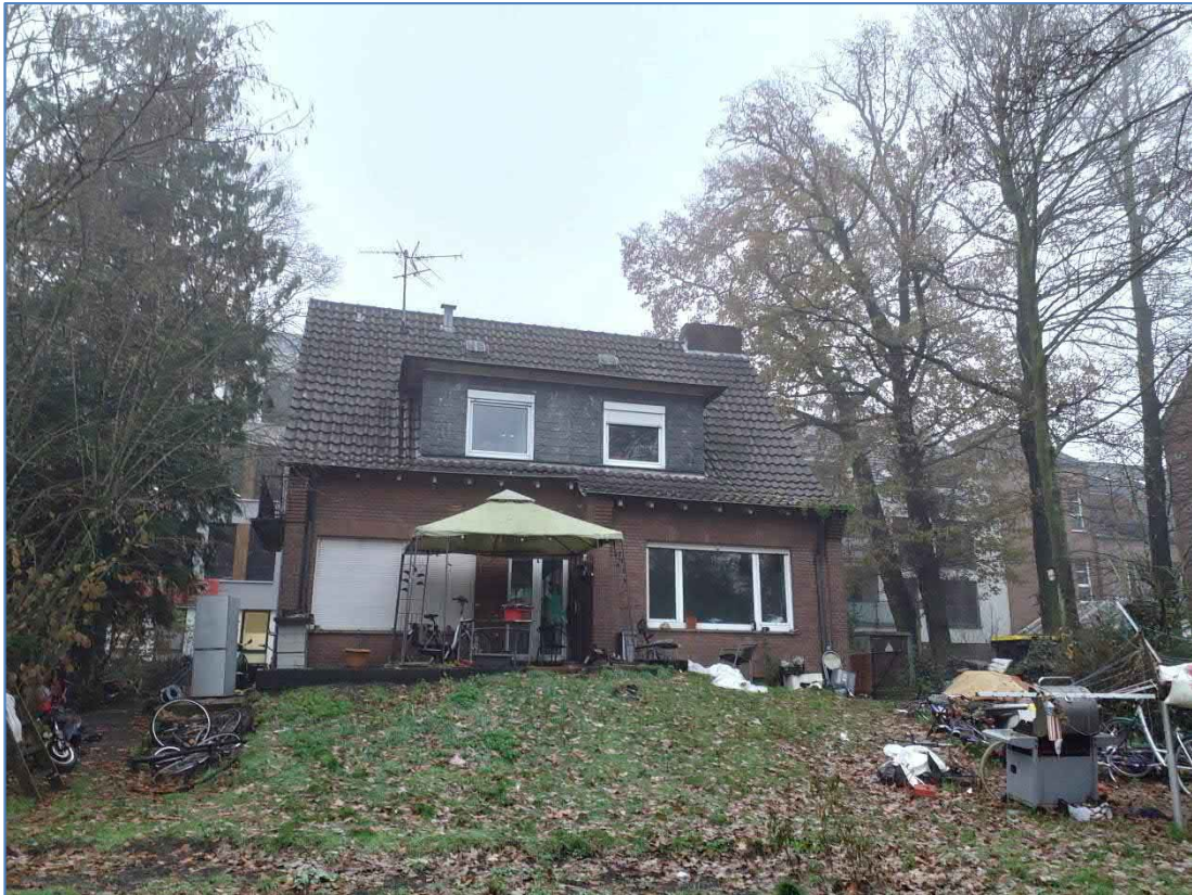
Abb. 6: Blick auf die hintere Gebäudefassade
