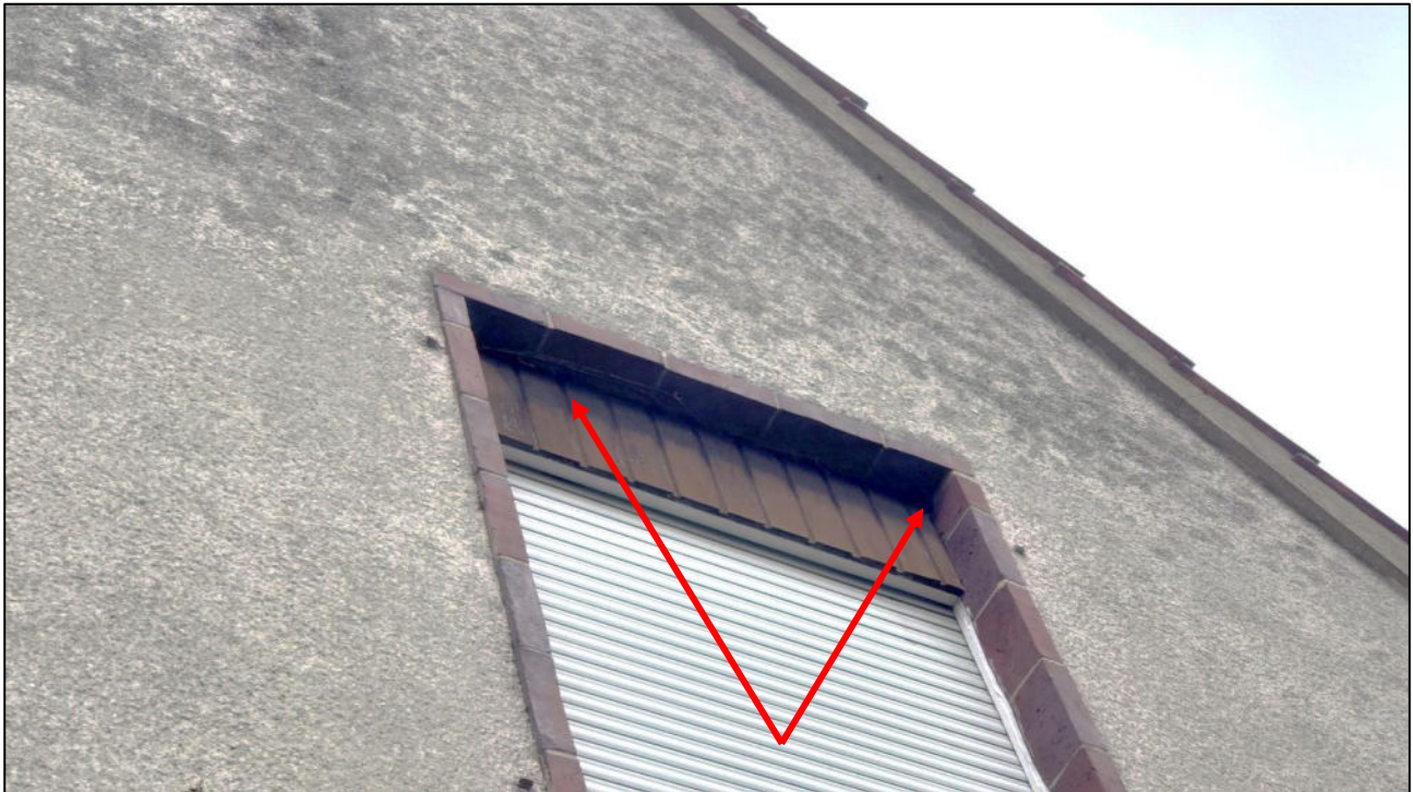
Foto 10: Einflugmöglichkeiten und Quartierpotenzial hinter Holzverkleidung (z.B. rote Pfeile) (30.10.2024).
