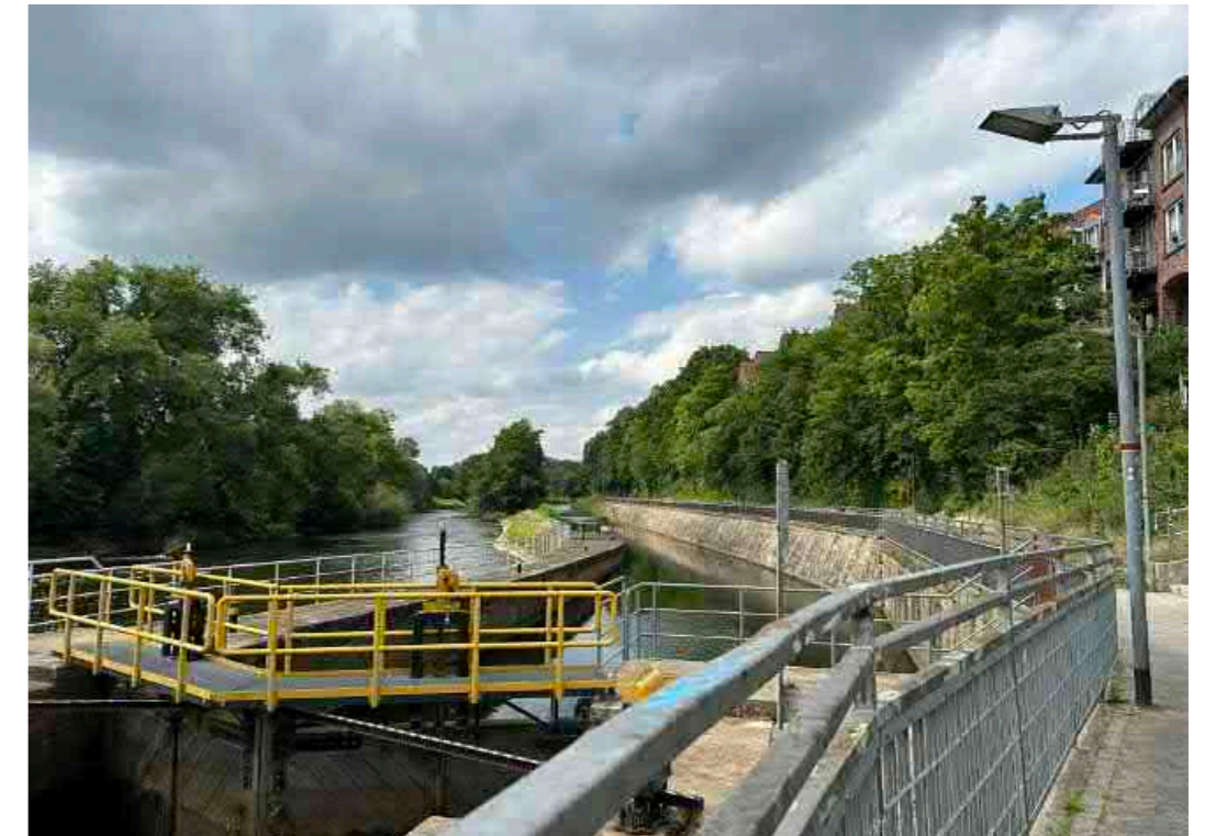
Abb.3: Schleuse und Mitteldamm am Emswehr
