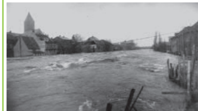
Aufnahmen vom Hochwasser 1964
