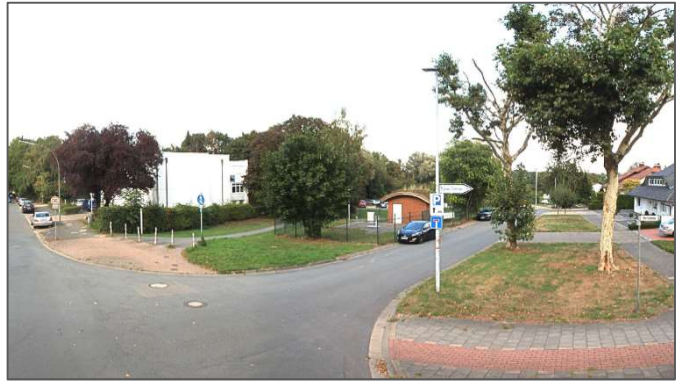
Links der Zufahrt ist im Bestand das Versorgungshäuschen für das unterirdische Regenüberlaufbecken des Änderungsbereichs (4. Änderung B-Plan Nr. 181) zu sehen
