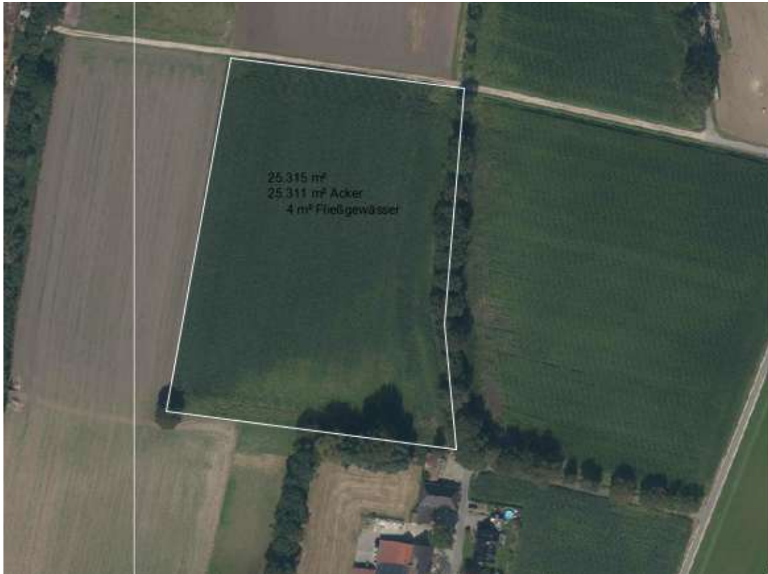
Abb. 4: Umgebung des Geltungsbereiches Teilbereich A (Quelle: Umweltdaten vor Ort)
