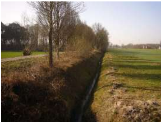
Foto 25: Graben an der Ostseite der Eingriffsfläche entlang der Fahrradstraße (© ILB Planungsbüro)
