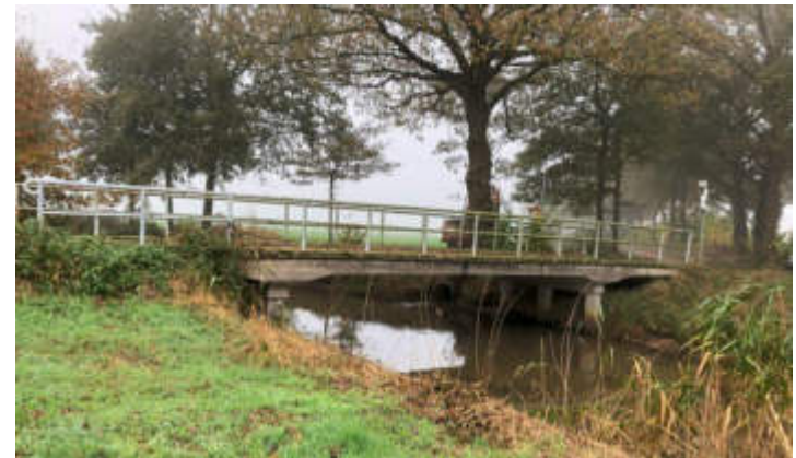
Beispiel: Brücke „Am Hof“ über den Hemelter Bach
