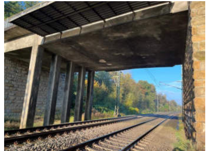
Beispiel: Brücke „Hohe Allee“ über die Bahn (Hamm-Emden)
